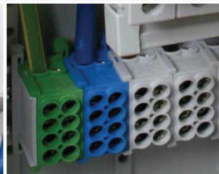
Les bornes assurent le raccordement des différentes lignes d'alimentation.
