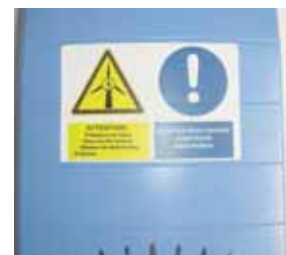
Apposer les signalisations sur les onduleurs
